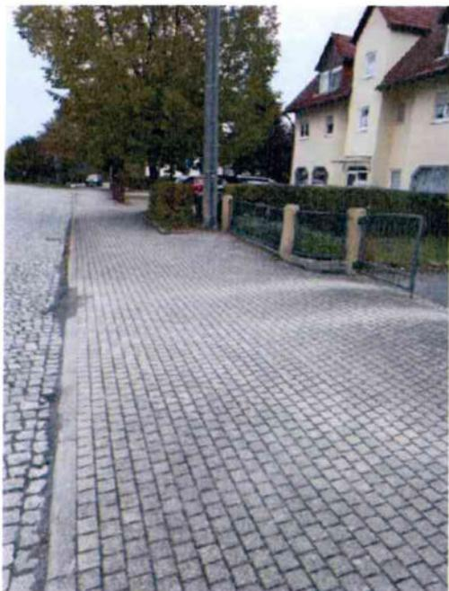
Die Aufstellfläche für die wartenden Fahrgäste ist ausreichend breit dimensioniert. Die Einstiegshöhe ist mit ein Bordanschlag von 8,00 cm bis 10,00 cm deutlich zu niedrig. Ein Fahrgastunterstand fehlt auf dieser Seite des Busplatzes.
